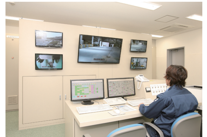
■中央操作室 施設全体の処理ラインを管理します。機器の状態や処理の状況を ITV モニタなどで監視し、安全で効率の良い運転を行います。
